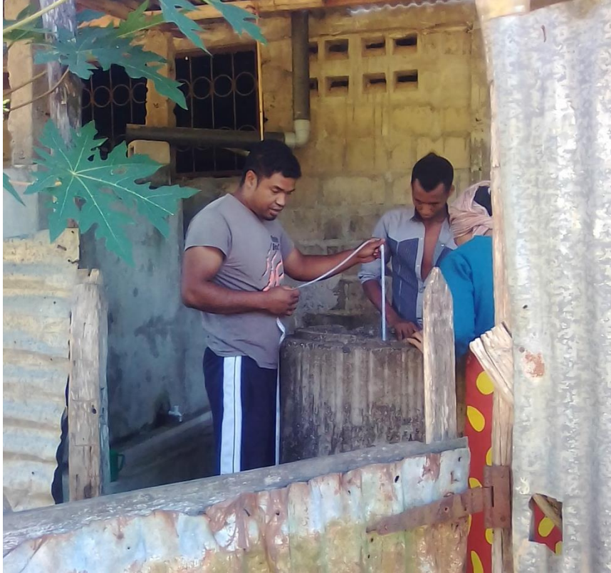
Mesure de niveau d'eau et de la profondeur du puits existant
